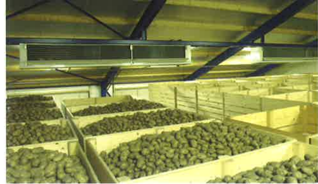
▲ Mechanische koeling vergemakkelijkt het inkoelen en op temperatuur houden van aardappelen aanzienlijk. Vooral bij pootaardappelen en bij lange bewaring van consumptieaardappelen zorgt mechanische koeling als regel voor een betere kwaliteit van het product. Wel nemen de bewaarkosten flink toe.
